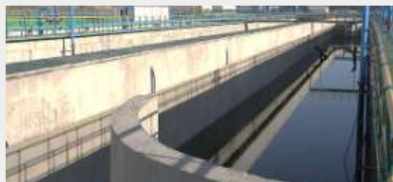
водные бассейны и очистные сооружения
